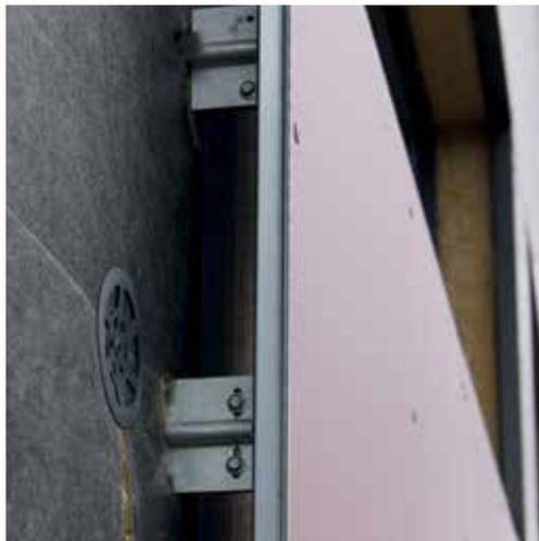
Gauche : ensuite, la platine de support est montée sur l'ancrage et la sous-structure peut être vissée ou rivetée en place.
