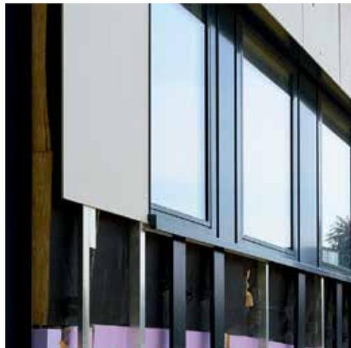
Gauche : la platine de support est ensuite fixée et la sous-structure est vissée ou rivetée.
