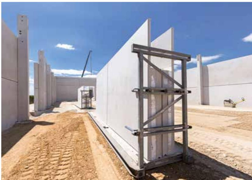
Nicht nur bei der Weinherstellung selbst, sondern auch bei den dafür benötigten Gebäuden, kommt innovative Technik zum Einsatz: Die einzelnen Schichten der Sandwichelemente mit innerer und äußerer Sichtbetonschale und zehn Zentimeter starkem Dämmkern werden bereits werkseitig durch den Schöck Isolink® verbunden.
