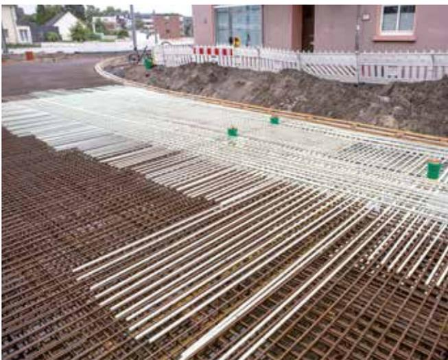
Um die Weichensperkreise nicht mit elektrisch leitfähigen Materialien zu beeinflussen, wird zur Bewehrung in diesem Bereich der Glasfaserverbundwerkstoff Combar® eingesetzt. Fotos: LEUCHTKRAFT – Stephan Raithel
