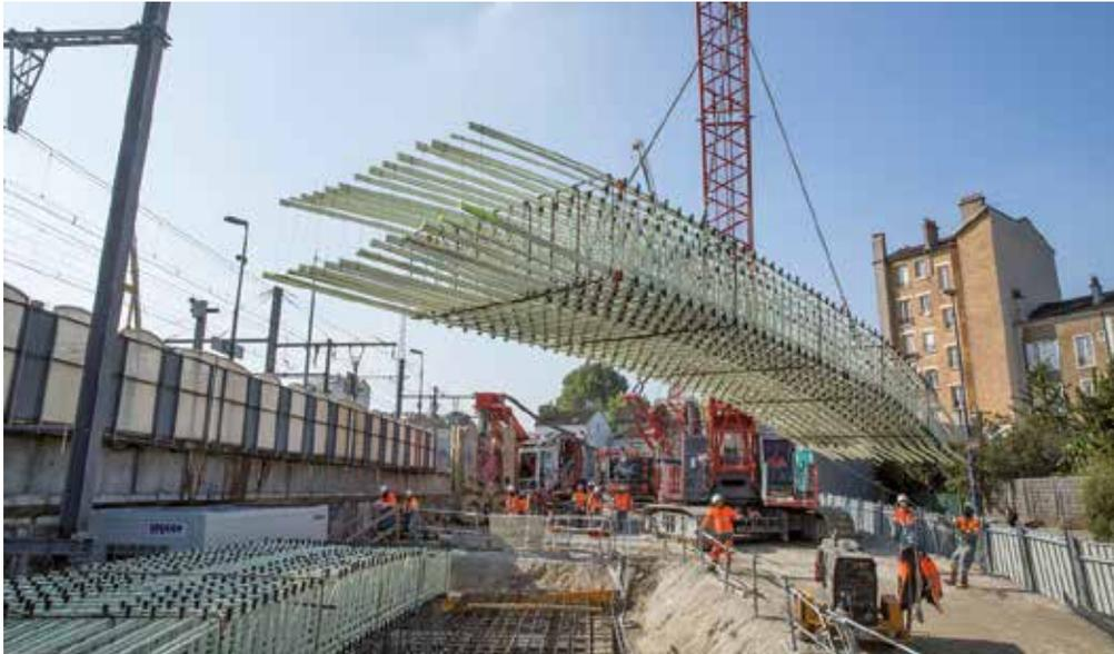
Die Glasfasersegmente sind mit diagonalen Combar® Stäben in beiden Richtungen zu einem stabilen Fachwerk ausgesteift. Dadurch können die gesamten Bewehrungskörbe ohne zusätzliche Aussteifungen aus Stahl über dem 40 Meter tiefen Schacht für die Schlitzwand in die Senkrechte gebracht werden, was eine zusätzliche Optimierung des Bauablaufs bedeutet.
