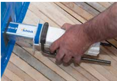
Rys. 9: Typ Q nasadzić tuleję biegu schodów
