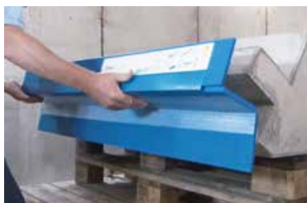
Rys. 4: Typ F - ustawić we właściwej pozycji i przykleić
