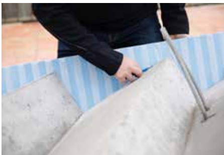
Rys. 6: Typ L – naciąć folię samoprzylepną
