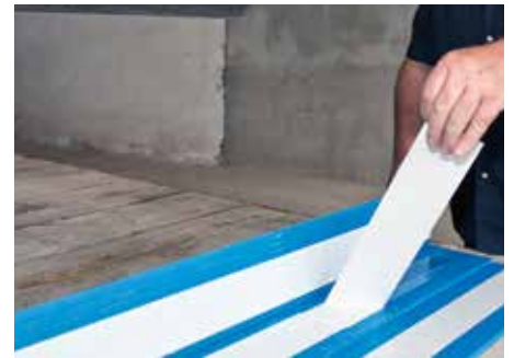
Rys. 2: Typ F - ściągnij folię ochronną
