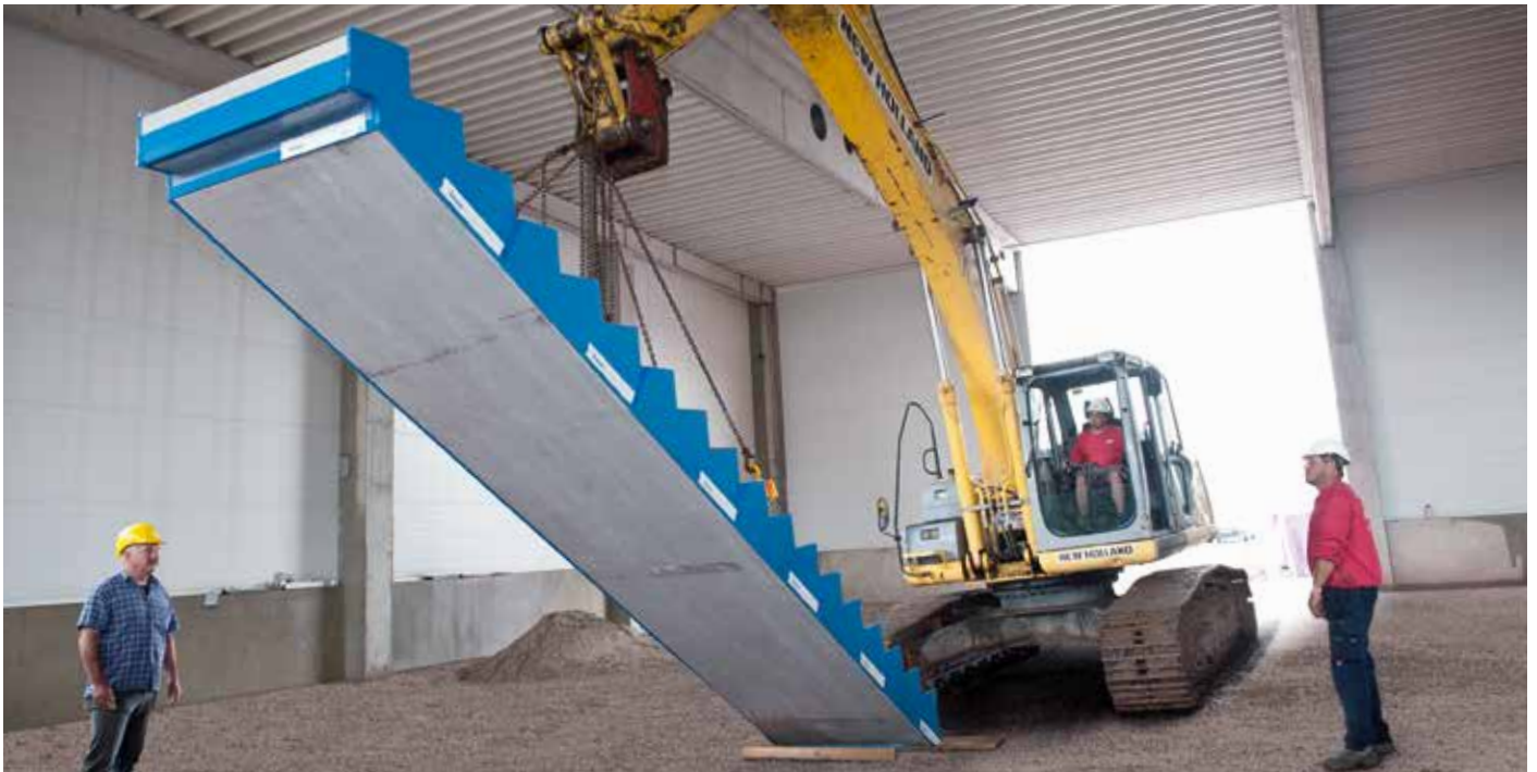
Rys. 11: Prefabrykowane schody oklejone na całym obwodzie Tronsole® mogą być montowane bezpośrednio na placu budowy.
