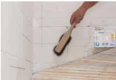
Rys. 3: Usunąć kurz i brud
