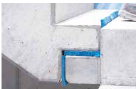
Rys. 13: Podparcie konsoli przy użyciu typu F
