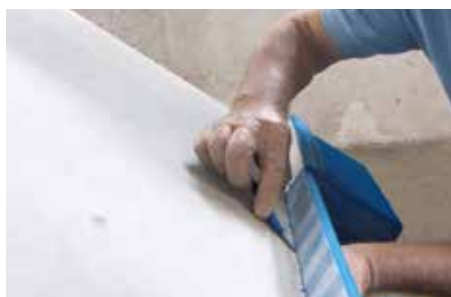
Rys. 6: Typ L – naciąć folię samoprzylepną
