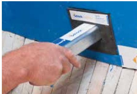
Rys. 7: Zamontować kotłierz przeciwpożarowy R 120. Typ Q - wsunąć element nośny
