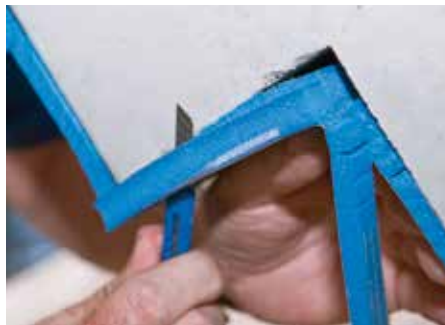
Rys. 4: Typ F - odciąć nadmiar długości
