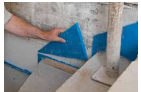
Rys. 11: Typ L - odciąć wystający fragment
