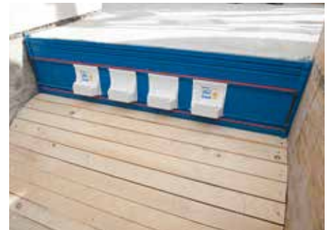
Rys. 2: Typ T - betonowanie podestu
