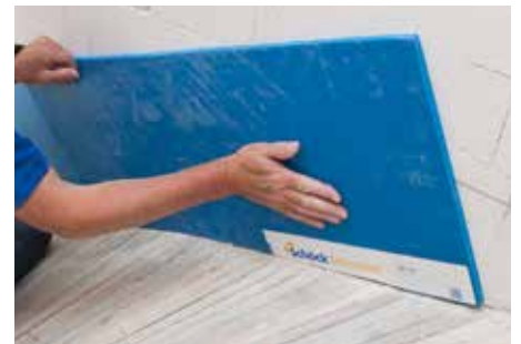
Rys. 5: Typ L - nakleić dolną połowę
