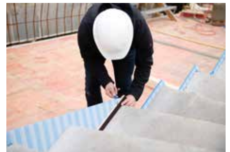
Rys. 8: Typ L - odciąć wystający fragment
