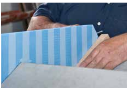
Rys. 9: Typ L - odciąć nadmiar długości
