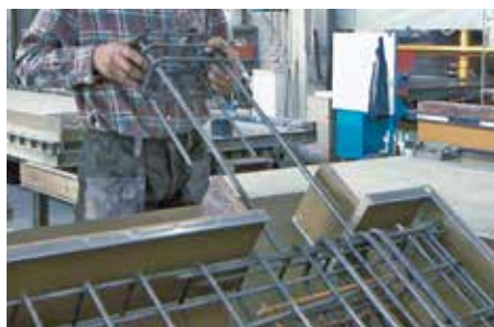
Rys. 1: Deskowanie schodów, montaż Tronsole typu Z Part T
