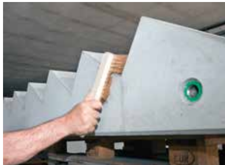
Rys. 1: Usunąć kurz i brud
