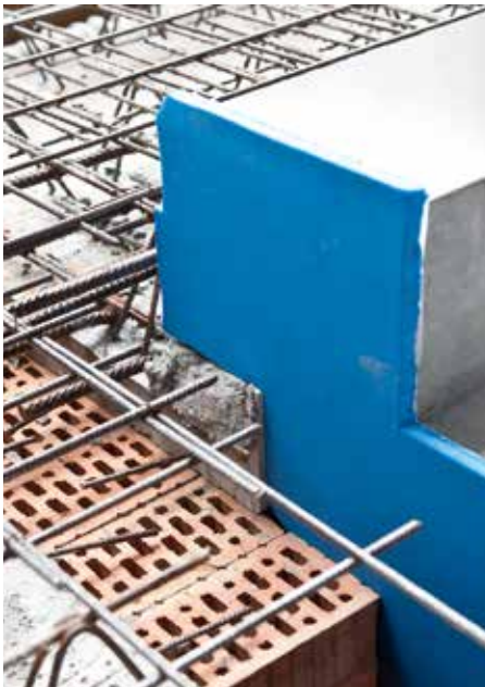
Rys. 12: Konsola jest akustycznie oddzielona dzięki zastosowanemu typowi F, a przy spoinie zastosowano Tronsole® typu L. Całość jest wolna od mostków akustycznych.
