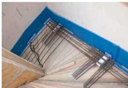
Rys. 10: Ułożyć zbrojenie i zabetonować
