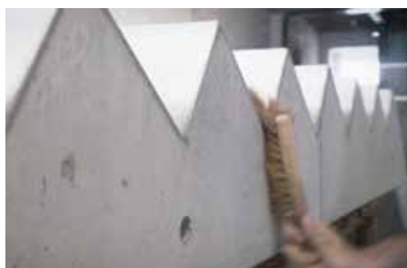
Rys. 3: Usunąć kurz i brud
