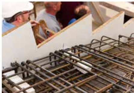
Rys. 4: Układanie zbrojenia i betonowanie
