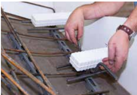
Rys. 3: Zamontować strzemię
