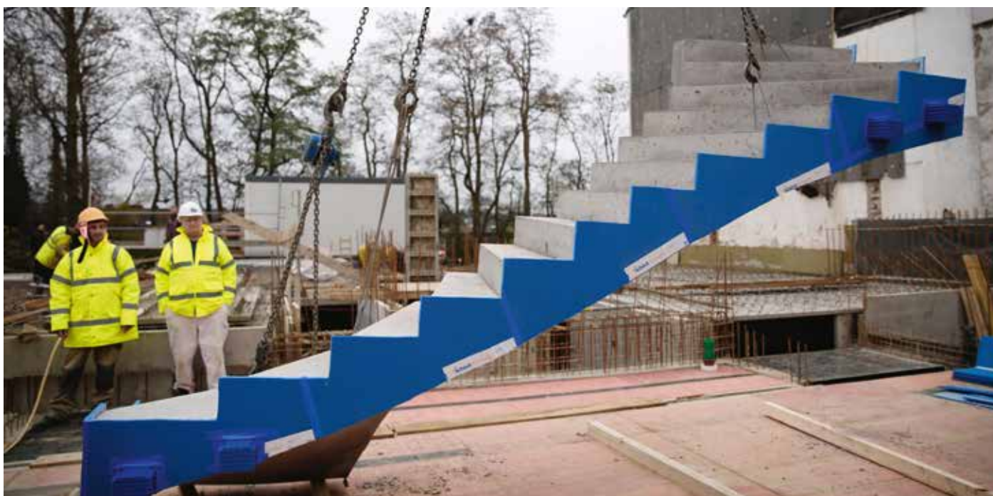
Rys. 11: Montaż schodów na placu budowy
