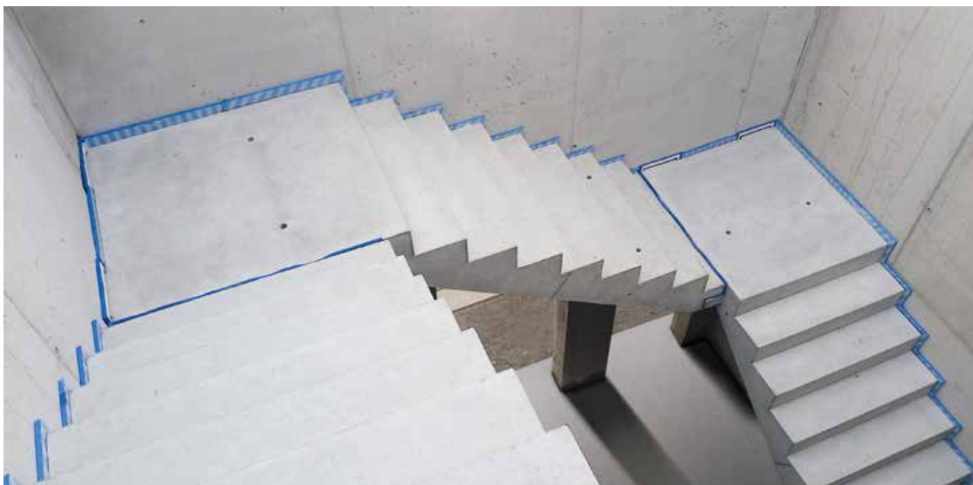
Rys. 15: Niebieska linia pokazuje montaż wolny od mostków akustycznych. Linia ta jest znakiem jakości potwierdzającym pewną izolację akustyczną.
