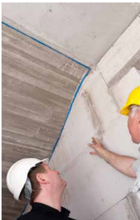
Rys. 13: Kontrola niebieskiej linii
