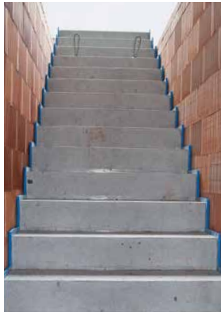
Rys. 13: Po montażu schodów otaczające je tęczniki Tronsole® tworzą widoczną, niebieską linię.
