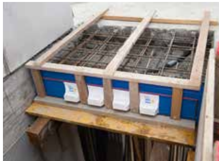
Rys. 1: Typ T - wsadzić i podeprzeć
