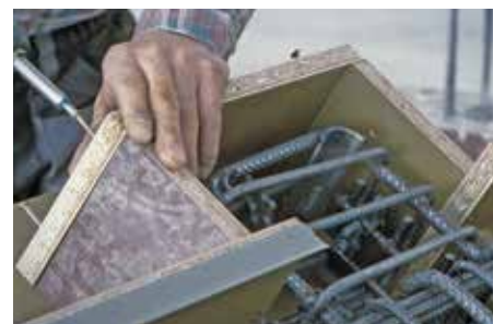
Rys. 2: Dokończyć deskowanie konsoli, następnie wykonać prace betonowe
