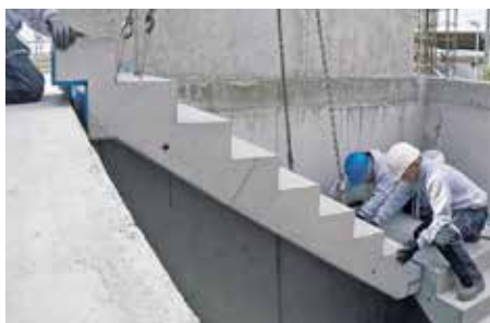
Rys. 12: Bieg schodów zostaje ustawiony we właściwej pozycji
