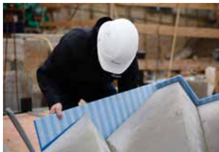
Rys. 7: Nakleić tącznik typu L
