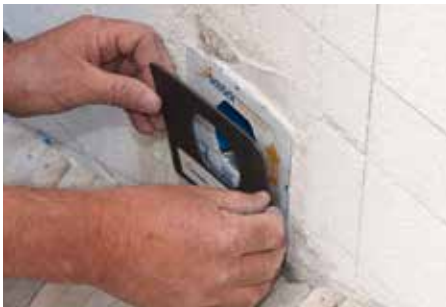
Rys. 6: Typ Q - wmurować element ścienny. Umieścić osłonę przeciwpożarową R 120
