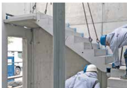
Rys. 10: Wsunąć i opuścić schody
