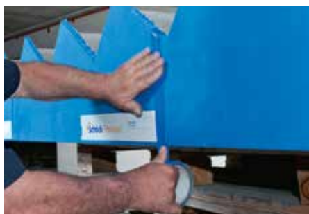
Rys. 10: Typ L - spoiny przykryć taśmą klejącą
