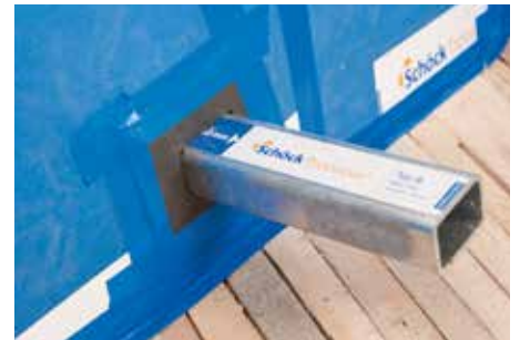
Rys. 8: Ostonić spoiny taśmą klejącą
