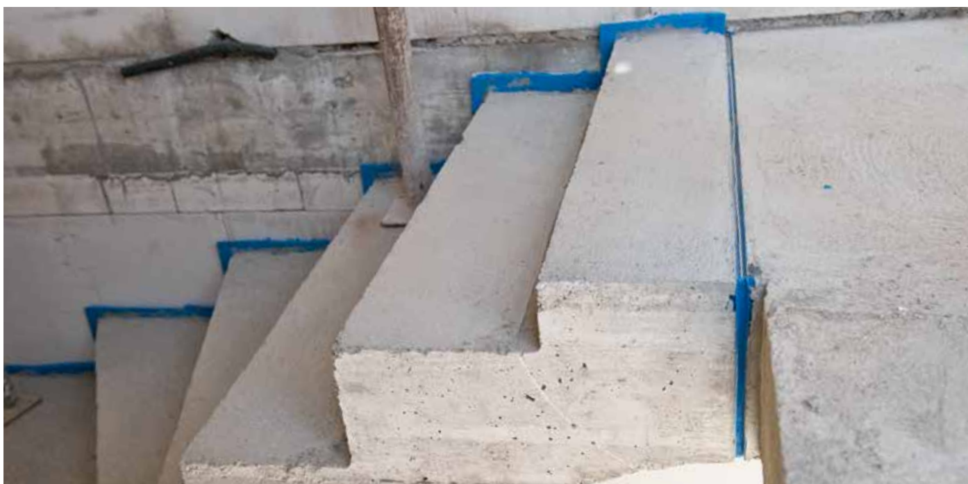
Rys. 12: Proste wykonywanie spoin przy końcu schodów
