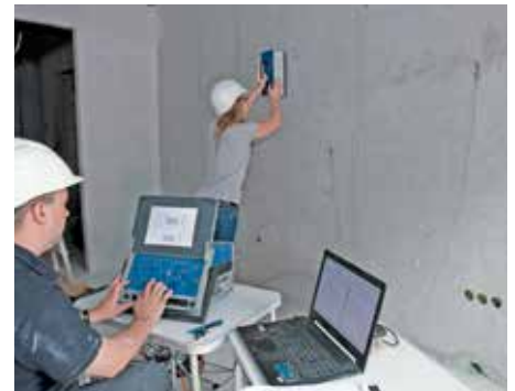
Pomiar czasu pogłosu dźwięku materiałowego ściany klatki schodowej.
