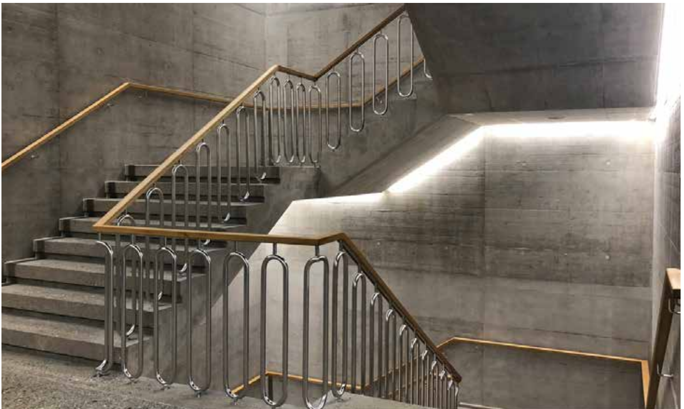
Klatka schodowa z betonu architektonicznego w Uniwersyteckim Centrum Stomatologii UZB, Bazylea
