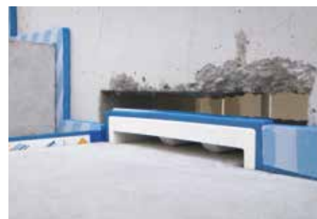
Rys. 11: Otwory w ścianach wypełnić zaprawą budowlaną
