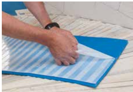
Rys. 4: Typ L - usunąć do połowy folię
