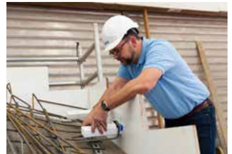
Rys. 2: Typ Q - zamontować tuleję w schodach
