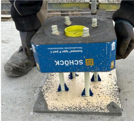
Das tragende Wärmedämmelement Sconnex Typ P dämmt Wärmebrücken an Stahlbetonstützen und macht Schluss mit Flankendämmung. Nun liegt auch die abZ für die Anwendung am Stützenfuß (Sconnex Typ P-U) vor.
