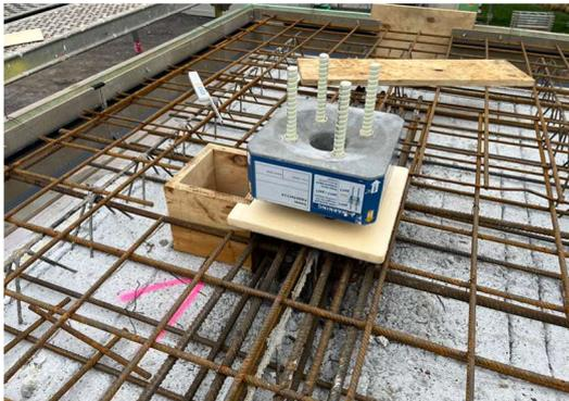
Die Verwendung des zum Patent angemeldeten Montagesets für Schöck Sconnex Typ P sichert die korrekte Einbauposition.
