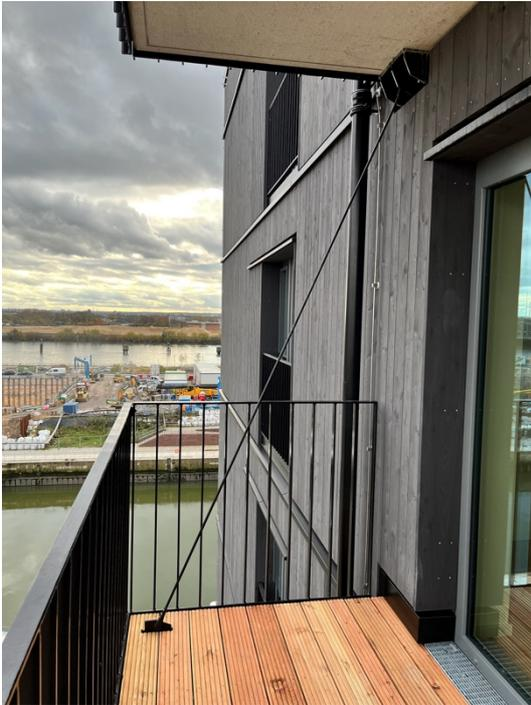
*Zugeisen für die sichere Lastabtragung der Balkone wurden an je einem Stahlwinkel in den beiden vorderen Ecken der Balkonplatten befestigt und schräg nach oben Richtung Wand bis zum darüberliegenden Balkon geführt.*
