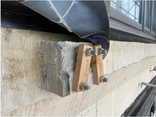
*Schöck Isokorb RT ist das einzige tragende Wärmedämmelement am Markt, das einen nachträglichen Einbau in Stahlbetondecken ermöglicht.
