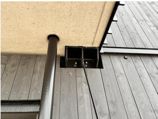
*Die Lösung für den tragenden und thermisch trennenden Anschluss der Balkonplatten aus Stahlbeton an die Geschossdecken aus Brettsperrholz gelang in einer Sonderkonstruktion mit Schöck Isokorb T Typ S.*
