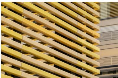
Die Fassadenbekleidung aus quadratischen, hohlen Keramikstäben, sogenannten Baguettes, in fünf Gelbtönen (RAL 1002, 1004, 1012, 1018 und 1021).
