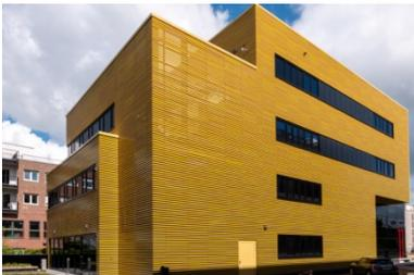
*Für eine besonders hochwertige und ästhetische Wirkung wurden die Keramikstäbe am ZDD Düsseldorf mit einer glatten Oberfläche versehen und im Finish glasiert.*
