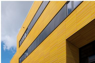
Markant: die Fassadenbekleidung aus glasierten Keramikbaguettes in verschiedenen Gelbtönen erzeugt ein dynamisches und zugleich edles Farbspiel.
