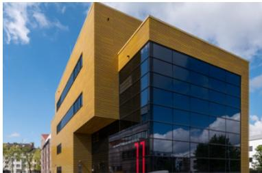
Das Zentrum für Digitalisierung und Digitalität, kurz ZDD, auf dem Campus der Hochschule Düsseldorf wurde nach dem Entwurf von RKW Architektur + aus Düsseldorf als markanter Kubus mit einer vorgehängten hinterlüfteten Fassade realisiert.
