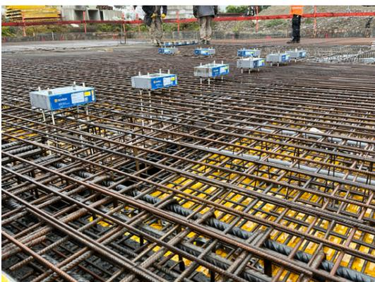
93 Sconnex Typ W wurden mit den zugehörigen Montagehilfen für eine schnelle und passgenaue Positionierung im Vinzenz Areal Wangen eingebaut.
