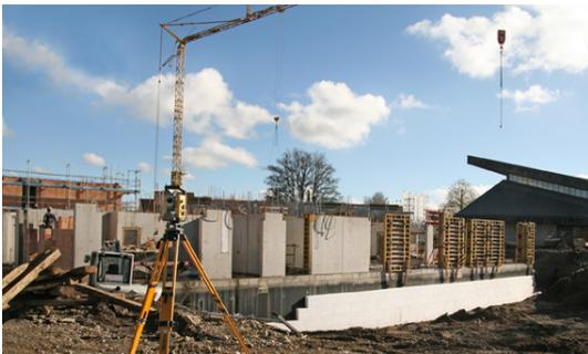
*Im Projekt Vinzenz Areal hat man sich für eine Aufdeckendämmung entschieden. Entstehende Wärmebrücken im Anschlussbereich zu den Wänden im Erdgeschoss wurden mit Sconnex Typ W thermisch getrennt.*
