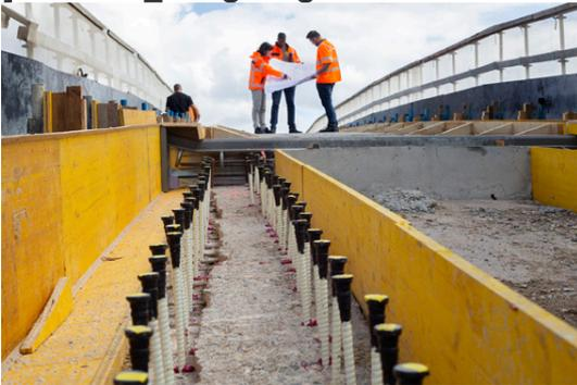
*Bei der Instandsetzung der Brücke wurde für die nicht metallische, korrosionsresistente Bewehrung Schöck Combar eingesetzt.
