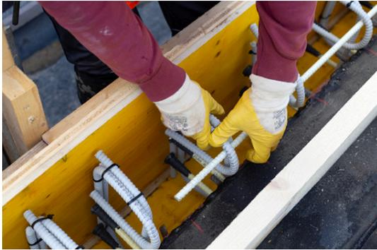
*Die Kappe wurde mit Combar Bügeln und Stäben bewehrt und mittels Kopfbolzen als Verbindungsanker zwischen dem Altbestand und den neuen Kappen verankert.*
