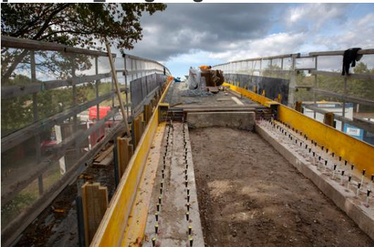
*Über die gesamte Länge des Bauwerks von rund 100 Metern wurde Combar als Bewehrung in den Brückenkappen verlegt.
