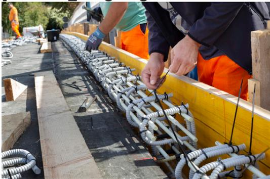
*Bei der Bewehrung mit Combar werden die Stäbe und Bügel mit Kabelbindern aus Kunststoff verrödelt, da dieser rostfrei ist.*
