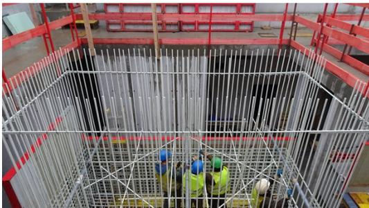
*Durch den Einsatz der Glasfaserbewehrung Schöck Combar am Zentrum für Angewandte Quantentechnologie (ZAQuant) der Universität Stuttgart konnten magnetische Störungen, ausgelöst durch Stahlbewehrung, vermieden werden.*
