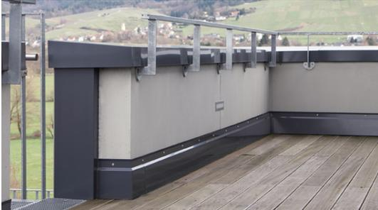
Beim Einsatz von CXT Typ A kann auf eine innenseitige Dämmung verzichtet werden, wodurch schlanke Attiken realisiert werden können, auch in Sichtbeton.
