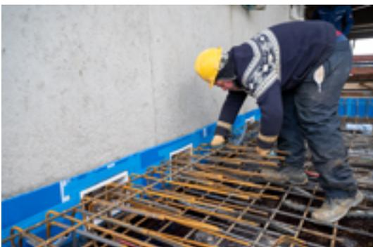
*Schöck Tronsole Typ Z ermöglicht den schalldämmenden Anschluss von
