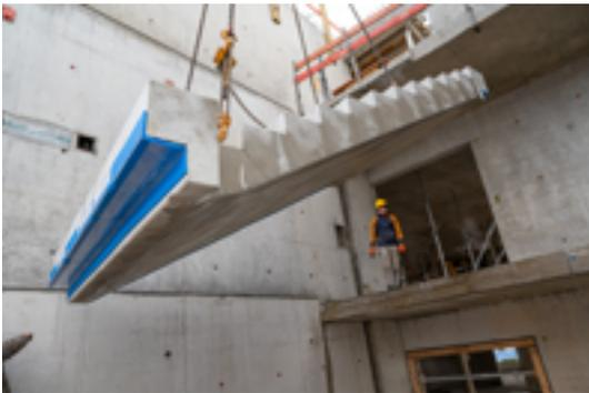
*Für den Anschluss Treppenlauf an Podest sorgt Tronsole Typ F.
