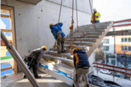
*Das Trittschalldämmsystem Schöck Tronsole entkoppelt die Bauteile vollständig voneinander, so dass auch der Fugenbereich vor Schmutz geschützt ist – für eine Ausführung ohne Schallbrücken.
