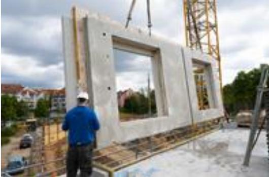
*Die Fassadenbefestigung Schöck Isolink aus Glasfaserverbundwerkstoff verbindet die Betonschalen der kerngedämmten Sandwichelemente und trennt diese zugleich thermisch. Foto: Schöck Bauteile GmbH*
