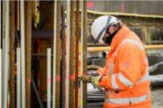
*Die Übergreifungsstöße zwischen den einzelnen Körben wurden mit Seilklemmverbindungen befestigt.
