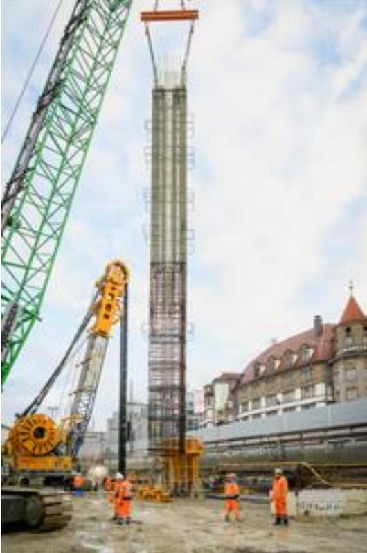
*Für die Herstellung der Schachtwände zeigte sich die Sonderlänge der Combar Stäbe von 18 Metern als vorteilhaft, denn auf diese Weise musste nur ein Bewehrungskorb erstellt werden.*
