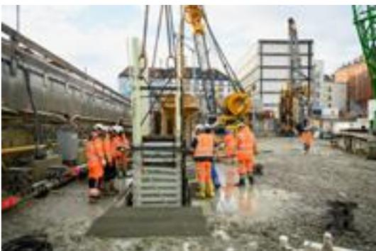
*Im Soft-Eye-Bereich wurden in einem Bereich von 24 Metern durchgängig Bewehrungskörbe aus Combar platziert.*
