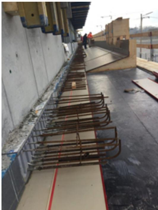
*Rund 80 verschiedene Isokorb Typen wurden direkt in die Ortbetondecken mit eingebaut, davon 40 Typen als Sonderausführung. Foto: Schöck Bauteile GmbH*
