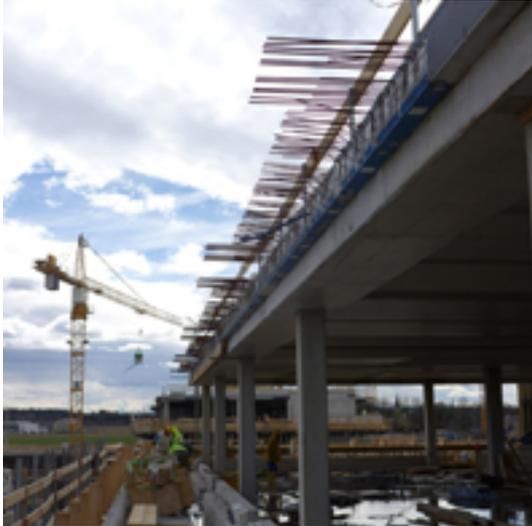
*Die Lösung, um Wärmebrücken im Bereich der Balkone zu reduzieren und die besonders starken Kräfte auf der Verbindung von Gebäude und Balkon aufzunehmen, fanden die Baubeteiligten im Schöck Isokorb XT. Foto: Schöck Bauteile GmbH*
