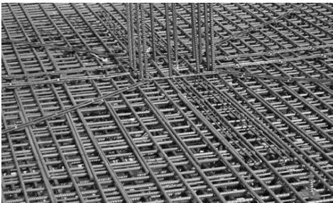
*Die Durchstanzbewehrung Schöck Bole Typ O wird einbaufertig geliefert. Für die schnelle Montage sind keine weiteren Teile notwendig. Foto: Schöck Bauteile GmbH*
