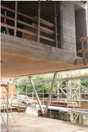
*Das Deckenelement kragt teilweise aus und wird von V-Stützen getragen. Foto: Schöck Bauteile GmbH*
