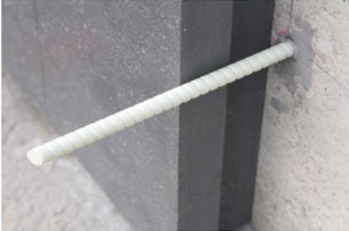
*Nach 24 Stunden war der Kleber ausgehärtet. Danach konnte die 16 Zentimeter dicke Wärmedämmung angebracht und die Vorsatzschale bewehrt, geschalt und betoniert werden. Foto: Schöck Bauteile GmbH*
