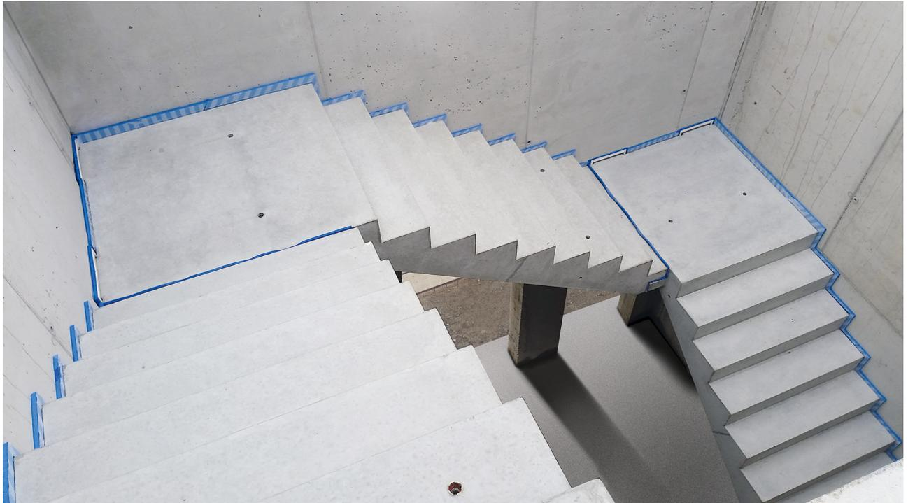
*Gerade Treppe mit Trittschalldämmung an den Anschlüssen und in der Fuge mit Schöck Tronsole. Foto: Schöck Bauteile GmbH, Abdruck honorarfrei.*
