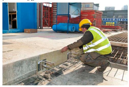
Das Fundament, die Decken-Wandanschlüsse und die Deckenunterzuganschlüsse wurden mit dem Schöck Schwerlastdorn vom Typ SLD-Q in verschiedenen Traglaststufen mit jeweiliger Brandschutzmanschette ausgeführt. Foto: Schöck Bauteile GmbH, Abdruck honorarfrei.
