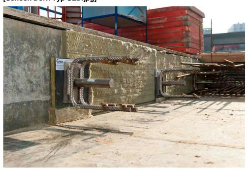
Der Schöck Dorn Typ SLD-Q besteht aus einem Hülsen- und einem Dornteil, die jeweils an der Fuge in die angrenzenden Gebäudeteile einbetoniert werden. Foto: Schöck Bauteile GmbH, Abdruck honorarfrei.
