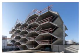
Die Umsetzung des Wabenhauses erfolgte in konventioneller Massivbauweise.
