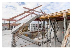
Die Waben bestehen aus horizontalen Ortbetondecken und schrägen Halbfertigteilen.
