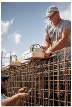
Das Wärmedämmelement Schöck Sconnex Typ W sorgt für die gewünschte schlanke Sichtbeton-Ästhetik der Basis und stellt die thermische Trennung zwischen dem Betonauflager und der Unterkonstruktion zum Holzbau sicher. Foto: Markus Schieder
