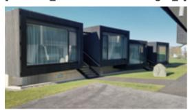
Zum dauerhaften Erhalt des satten Schwarztons der vorgesetzten vertikalen Lattenschalung wurde das Lärchenholz nach der japanischen Tradition Yakisugi karbonisiert, wodurch eine langlebige und wetterresistente Kohleschicht auf der Oberfläche entsteht.
