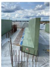
Die grün eingefärbten Brüstungselemente aus Beton wurden vorgefertigt auf der Baustelle angeliefert. Auch die tragenden Wärmedämmelemente Isokorb von Schöck waren bereits eingebaut.
