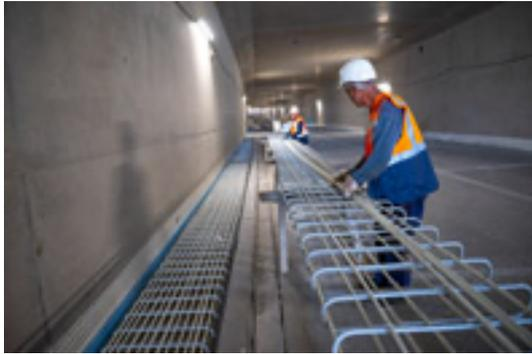
*Schöck Combar erreicht eine durch das Deutsche Institut für Bautechnik (DIBt) geprüfte Lebensdauer von 100 Jahren in Beton und ist derzeit der einzige, bauaufsichtlich zugelassene Faserverbundwerkstoff am Markt.*
