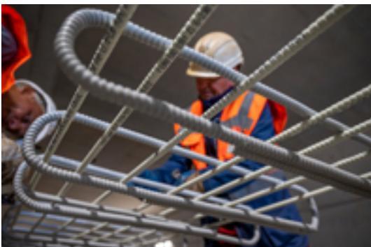
*Die GFK-Bewehrung von Schöck ist dauerhaft hochfest sowie zuverlässig korrosionsbeständig. Auch Tausalze können sie nicht chemisch angreifen.*
