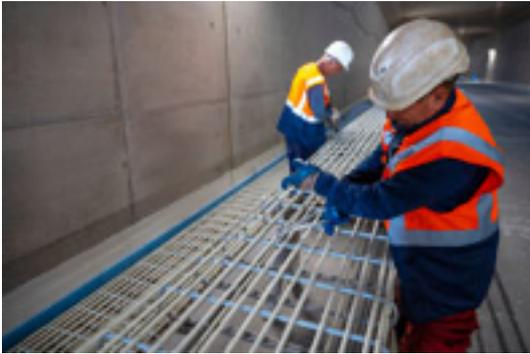
*Schöck Combar ist nicht nur korrosionsresistent, sondern auch wesentlich leichter als Stahl. Das Handling ist dadurch einfacher und für die Monteure weniger belastend.*
