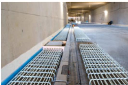
*Bei der Bewehrung des Notgehweges im Autobahntunnel Tutting setzt die Autobahn GmbH des Bundes, Niederlassung Südbayern auch auf Schöck Combar, die Betonbewehrung aus glasfaserverstärktem Kunststoff.
