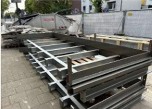
*Die Ankerplatten der Stahlkonstruktion mussten exakt zu den Kopfplatten am Schöck Isokorb RT passen, um eine biegesteife Verbindung zu gewährleisten.*
